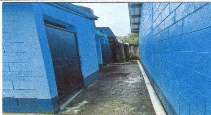
Foto1: Se dio mantenimiento a estructura (lijado, cambio de tubo, cepillado sujecion, aplicación de pintura puertas de baños) 98 x 180 mts2
