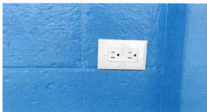
Foto 6: Sustitución de tomacorrientes
