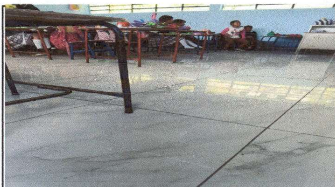
Foto 3: Sustitucion de piso en 5 aulas
