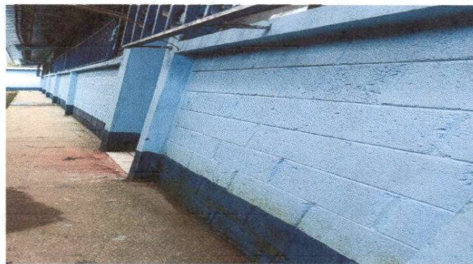
Foto 4: Pintura en muros exteriores e interiores
